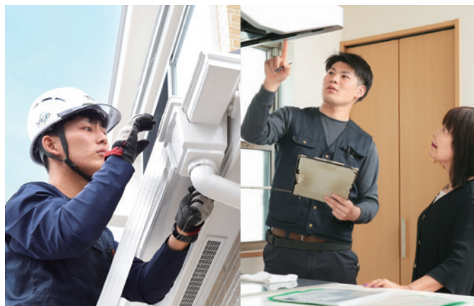
住宅点検の様子
